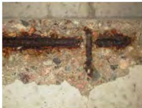
Exempel på skadad balkong. OBS! Annat objekt!
